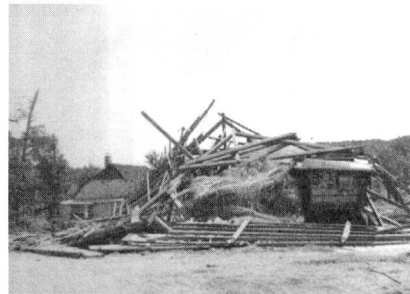
1. August 1958: Die nach dem Jahrhundert-Unwetter zerstörte Dreschhalle.
